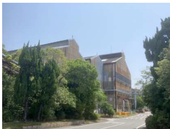
写真1 工場建屋の外観 (提供：神鋼鋼線工業(株)殿)
