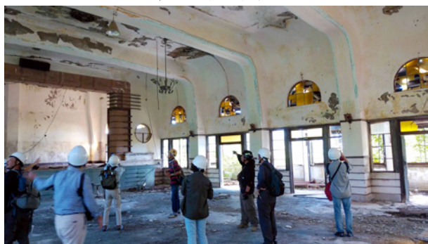
写真1 ホール見学の様子(撮影：寺島俊之)
