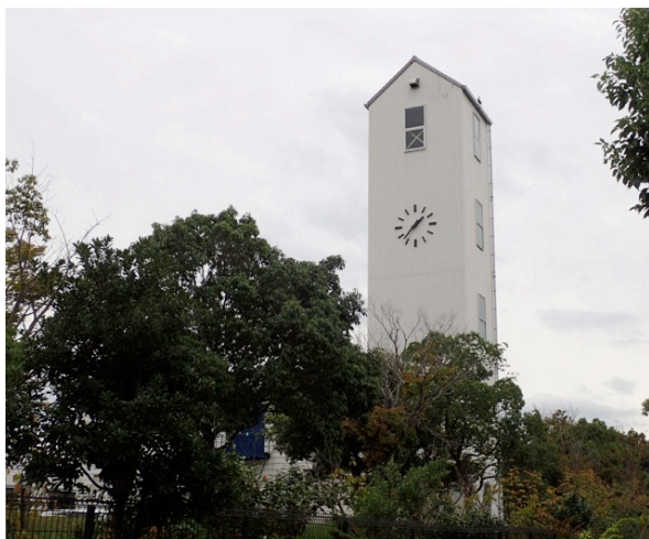
写真2 神鋼鋼線工業・二色浜地区のロープ試験塔(地上5階, 地下1階, 高さ約25m, 撮影：二階堂達郎)
