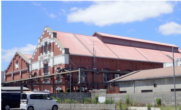
写真4 旧京都電燈・伏見第二火力発電所
