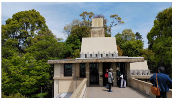
写真2 4階屋上から見るパラペット (撮影：寺島俊之)
