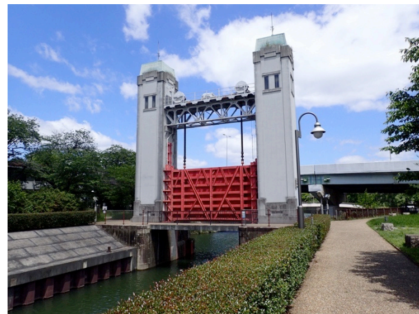
写真5 三栖閘門・後扉室 (撮影：二階堂達郎，2024/05/09)
